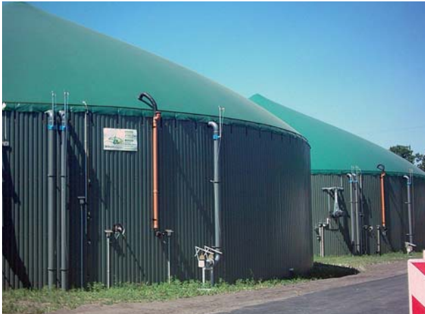
Fermenter einer Biogasanlage
