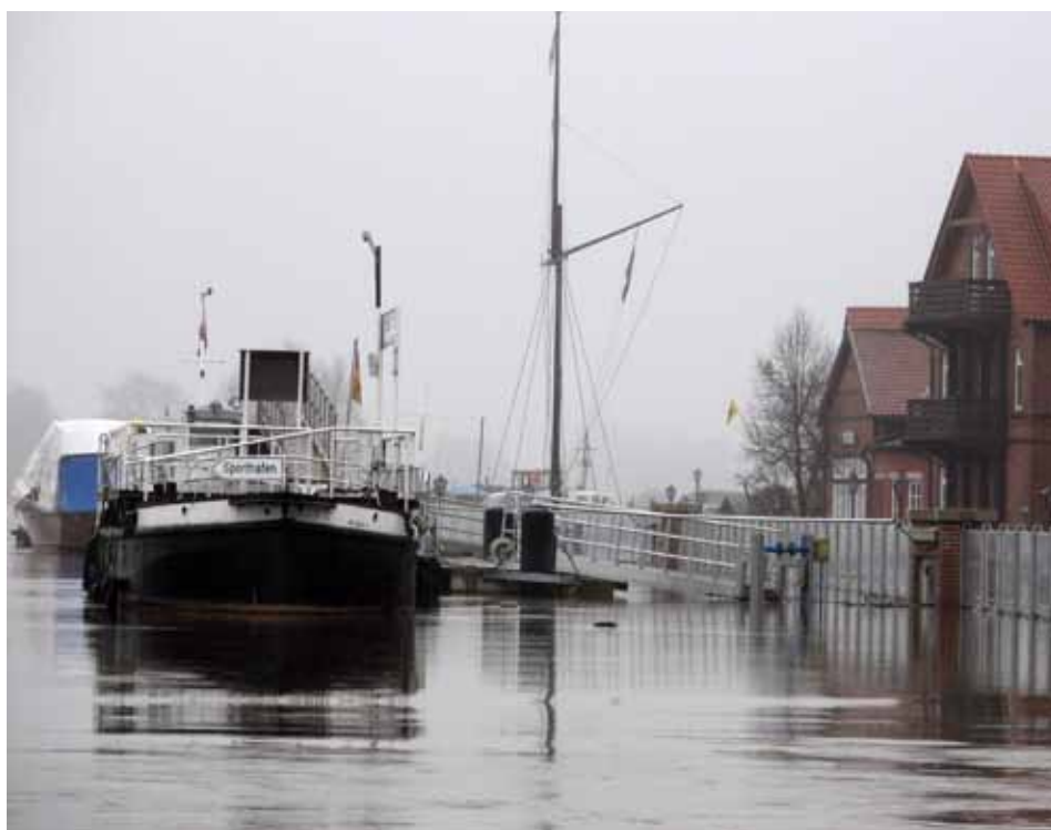
Teilmobile Hochwasserschutzwand beim Hochwasser Winter 2011
