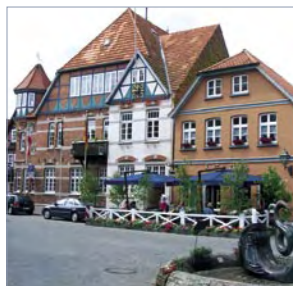
Verwaltungsgebäude im Alten Rathaus
