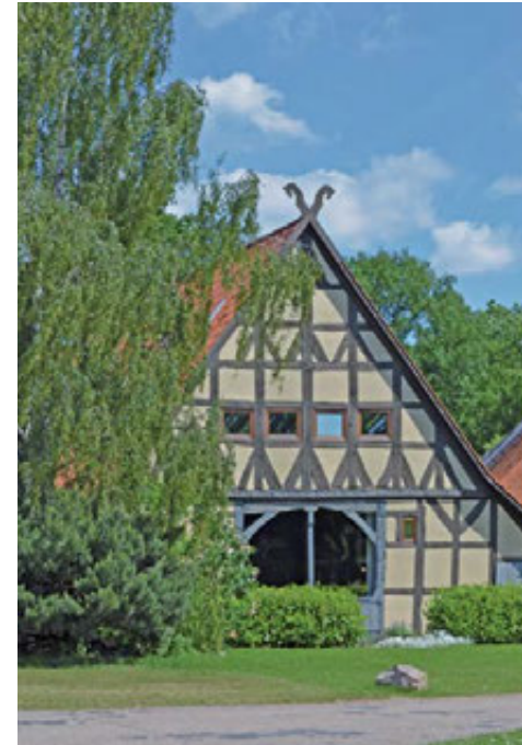
Das „100-Taler-Haus“ im Rundling Jameln wird so genannt, weil hier der Bauherr 1681 den Baupreis in den Spruchbalken schreiben ließ.
