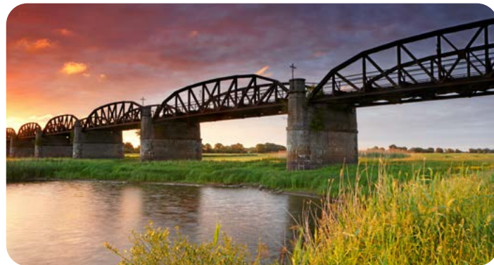
Baukultur, aufwändig restauriert – die Dömitzer Eisenbahnbrücke
