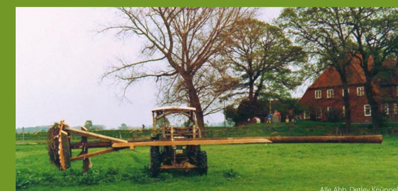
Fertige Nistunterlage wird mit Mast zum Standort transportiert und aufgestellt
