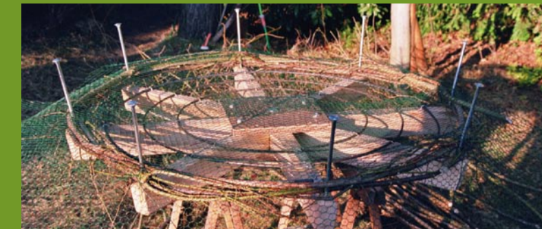
Auf ein stabiles Fundament wird Draht gespannt, damit kein Marder von unten eindringen kann
