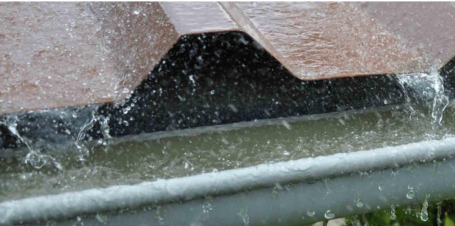
Abb. 5.4.1: Überlauf einer Dachrinne nach einem Starkregenereignis [5].
