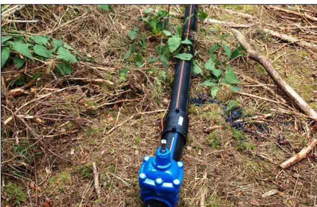
Abb. 6.5.3: Schlauchsystem zur Versickerung von Klarwasser im grundwasserfernen Kiefernwald (E. Eiben)
