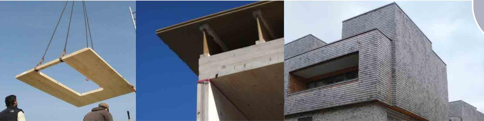
Abb. 5.8.1: (links und mitte) Bau des Versuchshauses aus Massivholz auf FH-Campus (G. Conradi)
