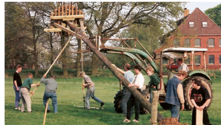
Errichtung einer Nistunterlage
