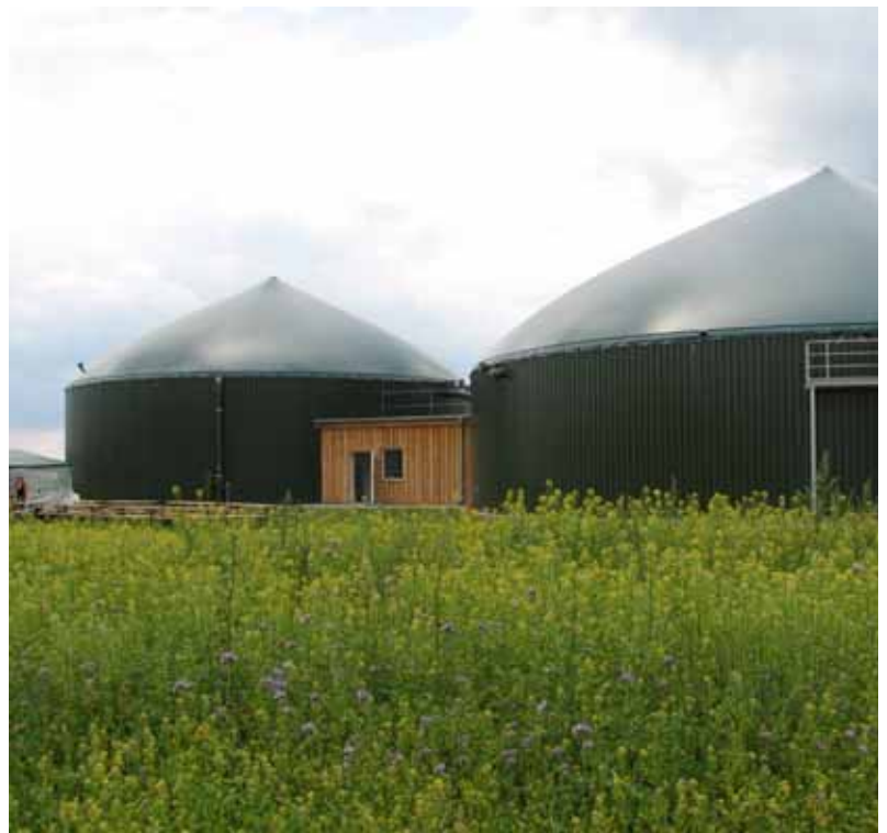
Biosgasanlage im Biosphärenreservat
